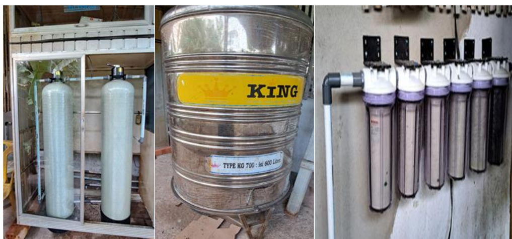
Gambar. 3. Rangkaian alat pengolahan air berteknologi membran ultrafiltrasi
