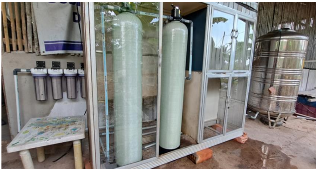
Gambar. 3. Rangkaian alat pengolahan air berteknologi membran ultrafiltrasi
