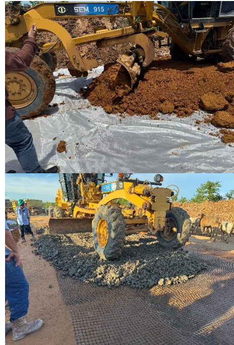
Gambar 7. Penghamparan di atas geotekstil dan geogrid
