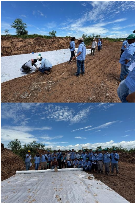
Gambar 6. Pemasangan geotekstil MACTEX® W2
