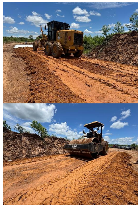
Gambar 8. Pemadatan tanah di atas geosintetik
