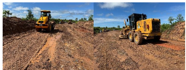
Gambar 4. Pemadatan tanah dasar
