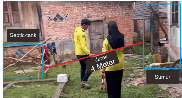
Gambar 3. Lokasi dan Pengukuran Jarak Sumur dan Tangki Septik
