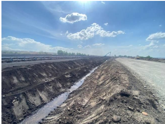
Gambar 17. Pembentukan tanggul jalan dan saluran
