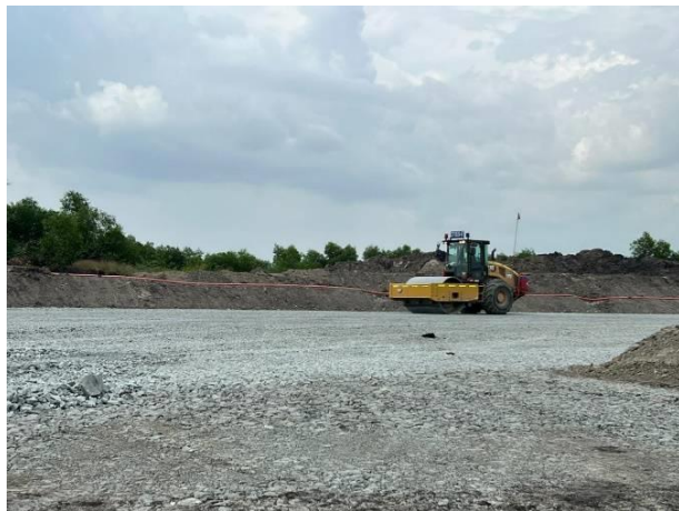
Gambar 16. Pemadatan material batu dengan vibro roller compactor
