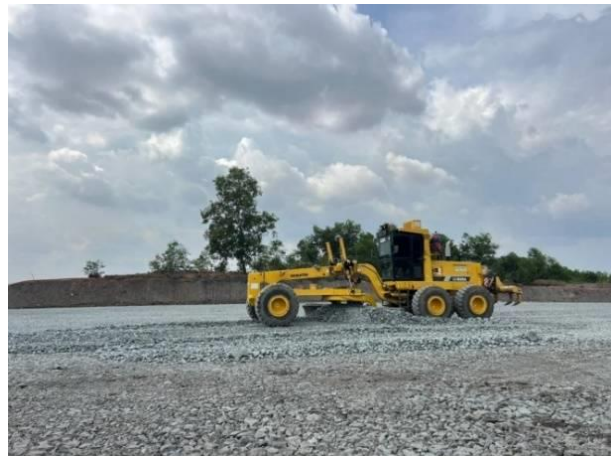
Gambar 15. Penghamparan material batu dengan motor grader
