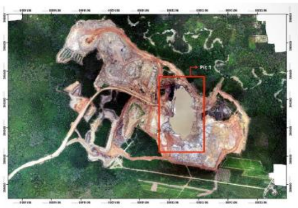
Gambar 1. Pit 1 PT Cakra Bumi Energi
