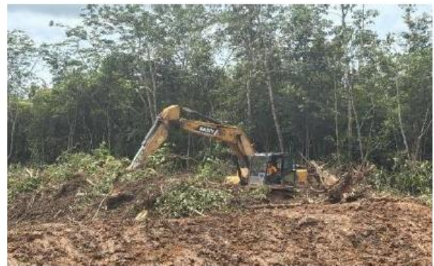
Gambar 2. Land Clearing dengan menggunakan Excavator
